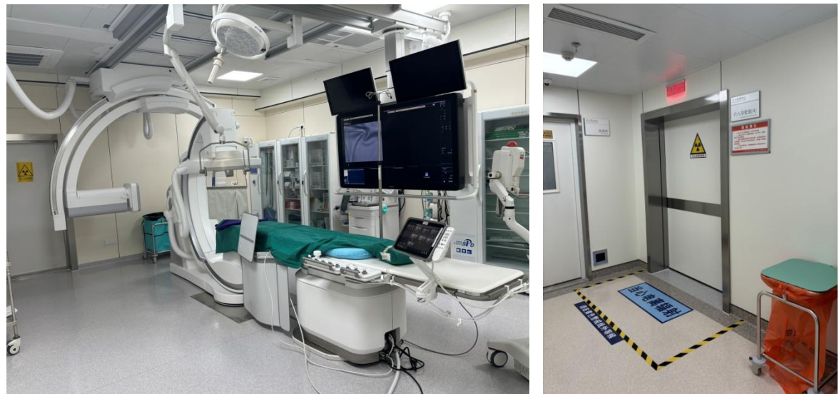
图4-1 公园路院区门诊楼二层外周导管4室DSA、受检者候诊门、工作状态指示灯、电离辐射警示标志及黄色警戒线
